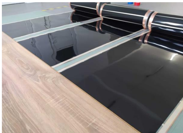
Ogrzewanie podłogowe
